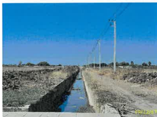
รางระบายน้ำฝน และบ่อน้ำฝนแห่งที่ 2
